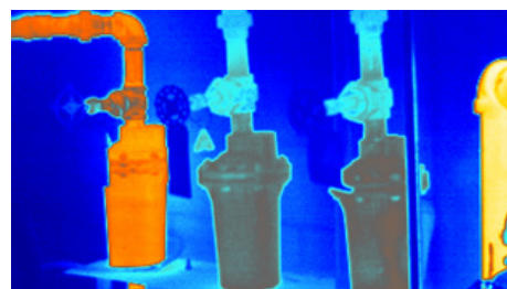
暖通空调检修
